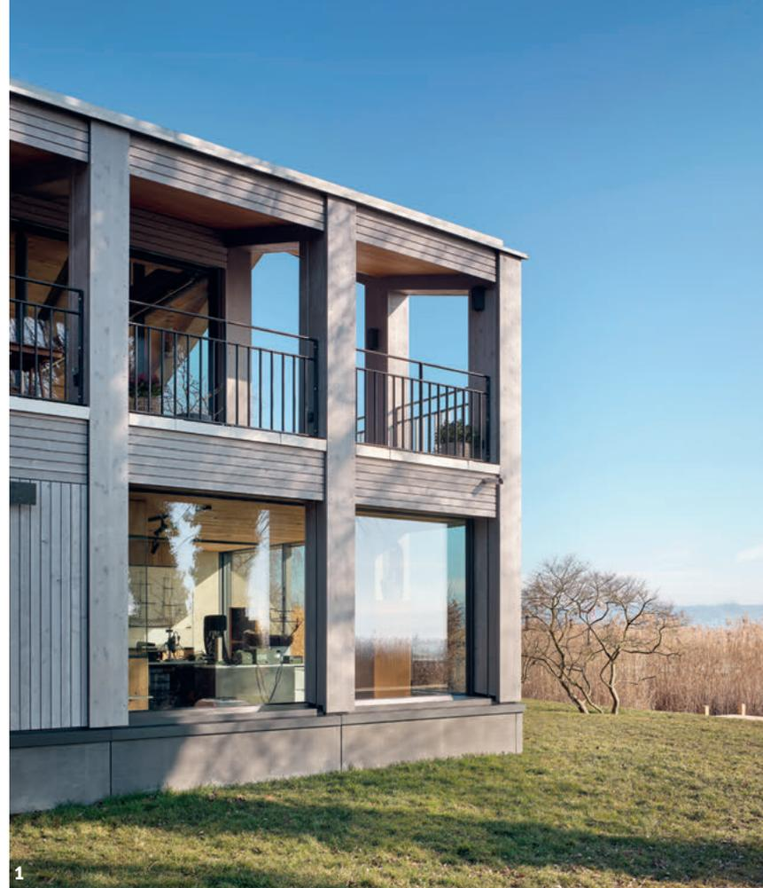
**1** Auf dieser Aufnahme sind die Konsolen aus gefärbtem Beton gut ersichtlich, welche zum Schutz vor Hochwasser rund um das Erdgeschoss angebracht sind.
